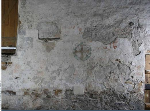
Südwand, der Sockelbereich im Überblick: Fehlstellen im Mörtel und Schäden, die u.a. durch Salze entstanden sind
