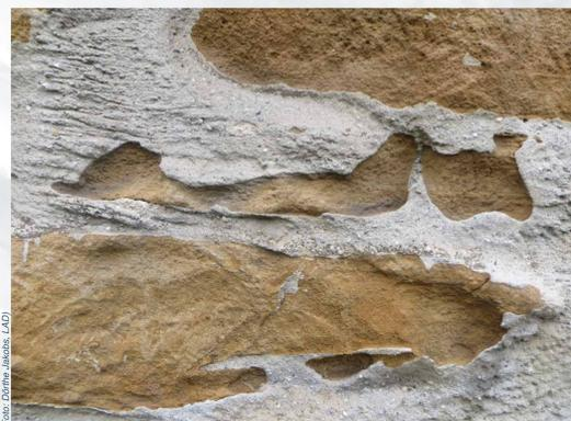
Durch falsches Fugenmaterial und Phasenwechsel von Salzen entstandene Schäden an der Außenhaut der Siechenkapelle (s. auch Außenmaßnahmen)
