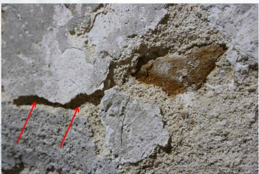
Starke Putzschädigung aus jüngerer Zeit: Die Randanböschung einer jüngeren Konservierung aus den 1990er Jahren ist bereits wieder zerstört (Pfeile). Je nach Feuchtigkeit nehmen Salze an Volumen zu oder ab, kristallisieren aus oder gehen in Lösung. Diese immer wiederkehrenden „Phasenwechsel“ führen zu Sprengungen und Lockerungen und damit zum Abfallen von Putzen und Malschichten
