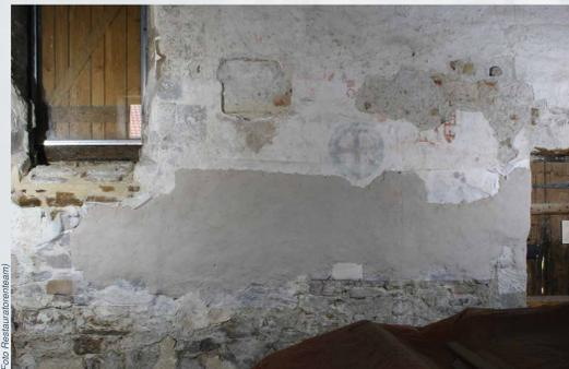
Entsalzungskompressen auf der Südwand. Eine Kompressen ist ein möglichst großporiger Putz ohne Bindemittel, der im feuchten Zustand die oberflächennahen Salze in Lösung bringt, durch seine putzähnliche Struktur den Verdunstungshorizont aus der Ebene der Putze in die Ebene der Kompressen verlagert und somit die oberflächennahen Salze aus der Mauer in die Kompressen zieht. Diese können dann mit der Kompressen abgenommen werden
