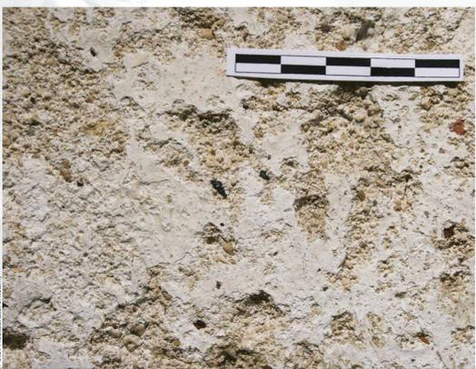
Kleinteilige Putzausbrüche und Putzabspregungen durch schädliche Mauer- und Putzsalze
